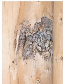
Trotz Verwucherungen eignet sich dieses Rundholz für den Bau.
