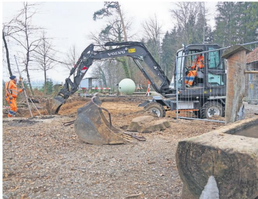
Diese Woche erfolgten die Aushubarbeiten für Fundament und Abwassertank (im Hintergrund).
