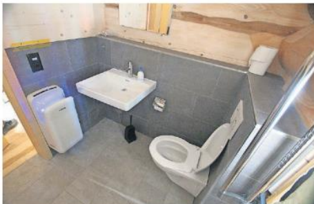
Die Ende Juni von Vandalen demolierte WC-Anlage wurde bis zum Eröffnungsfest wieder komplett erneuert.
